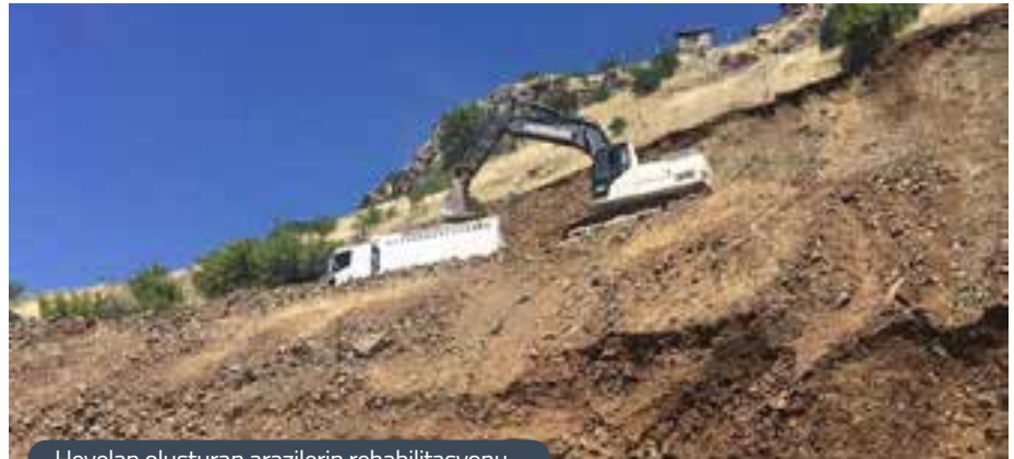
Heyelan oluşturan arazilerin rehabilitasyonu
