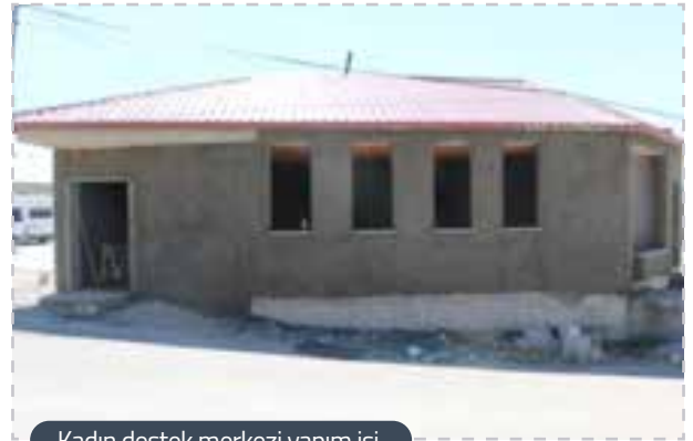
Kadın destek merkezi yapım işi
