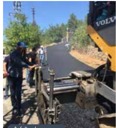
Asfalt yol yapımı
