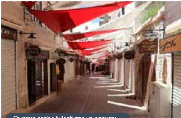
Çarşının cephe iyileştirme ve onarımı
