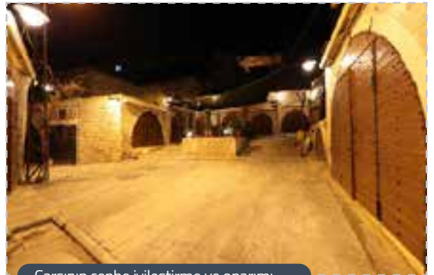
Çarşının cephe iyileştirme ve onarımı
