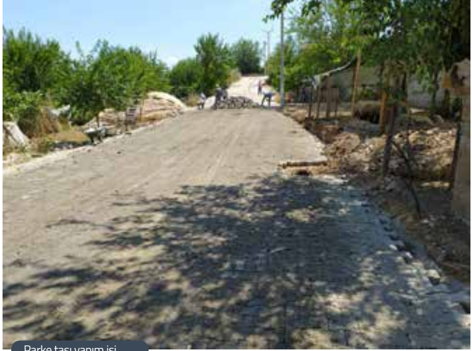
Parke taşı yapım işi
