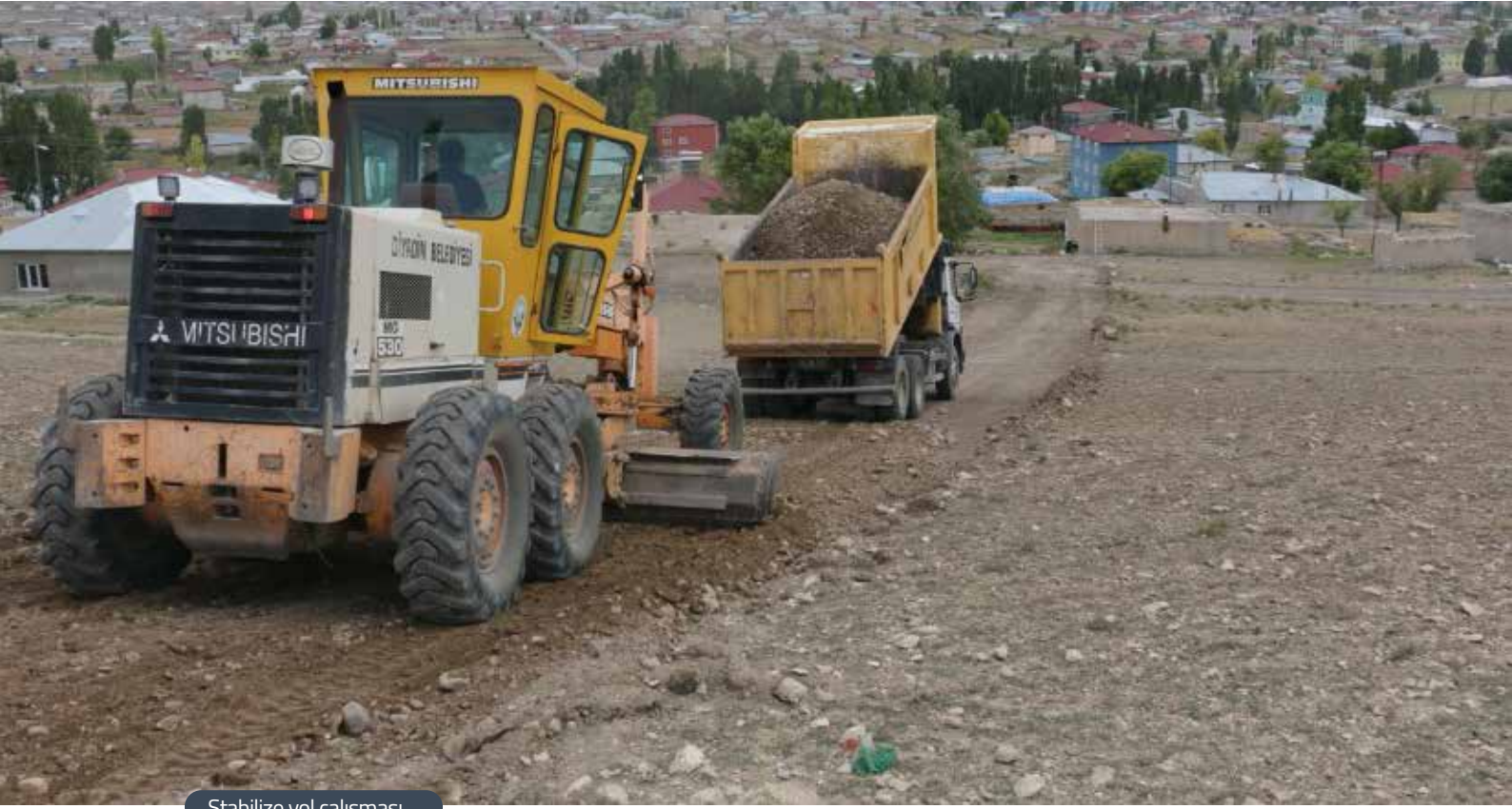
Stabilize yol çalışması
