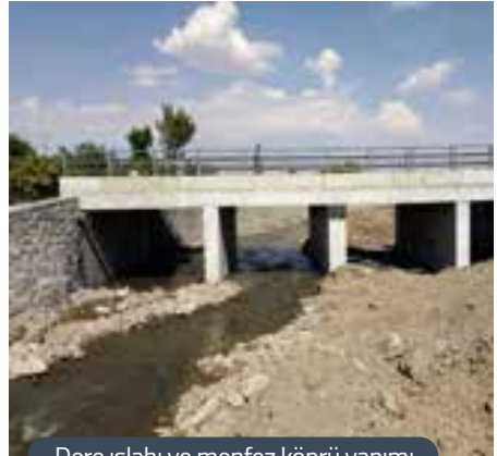
Dere ıslahı ve menfez köprü yapımı
