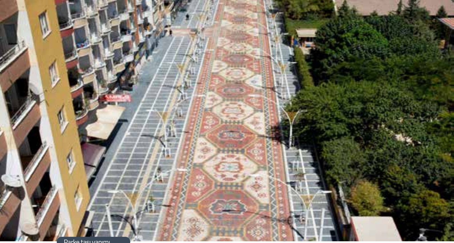
Parke taşı yapımı
