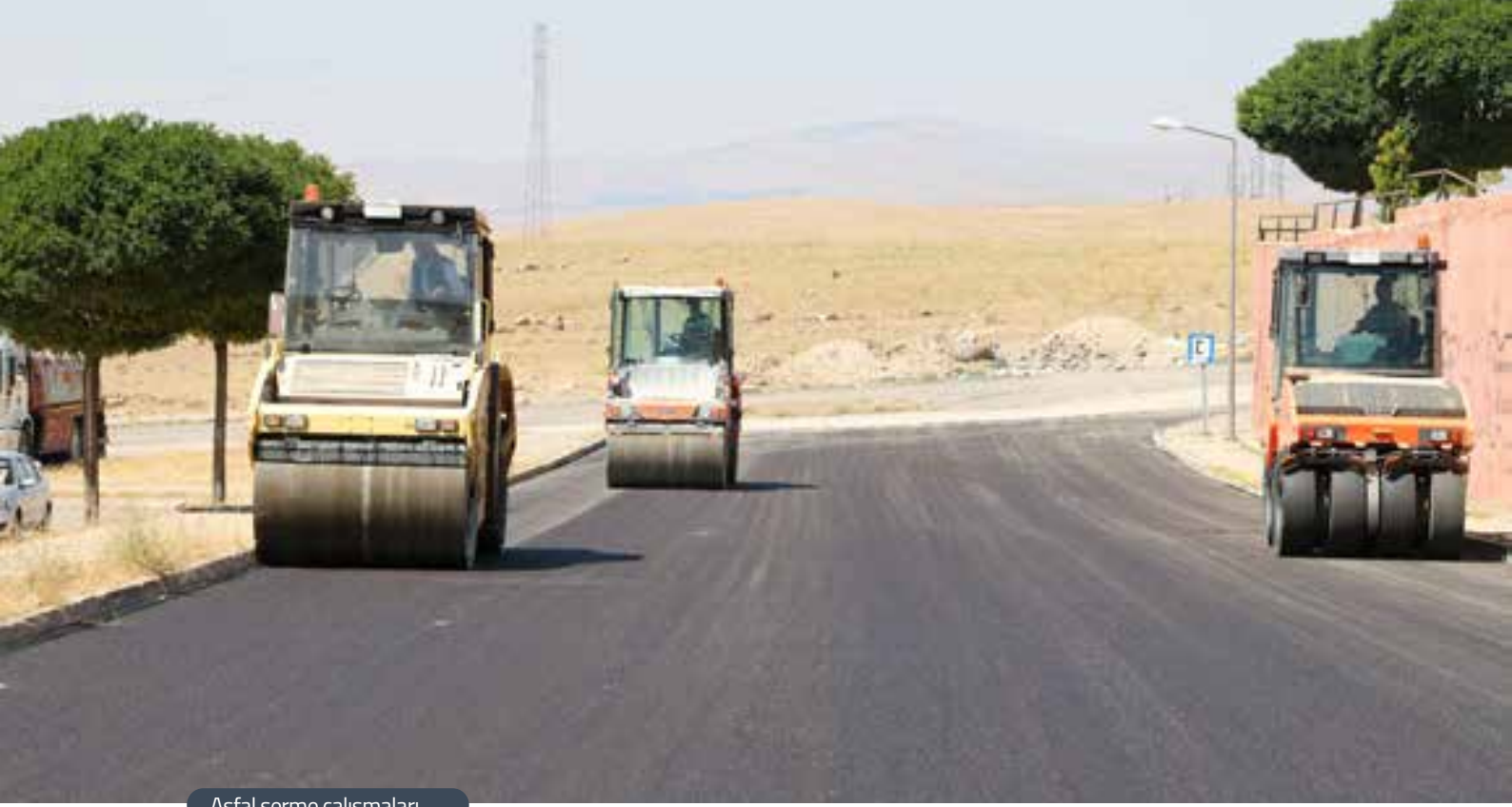
Asfal serme çalışmaları
