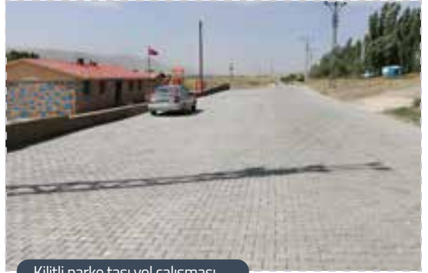
Kilitli parke taşı yol çalışması
