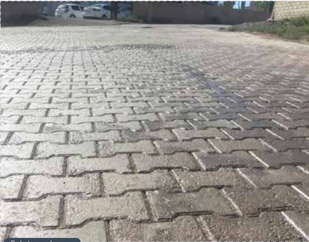
Parke taşı yapılması
