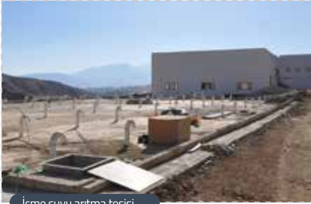
İçme suyu arıtma tesisi
