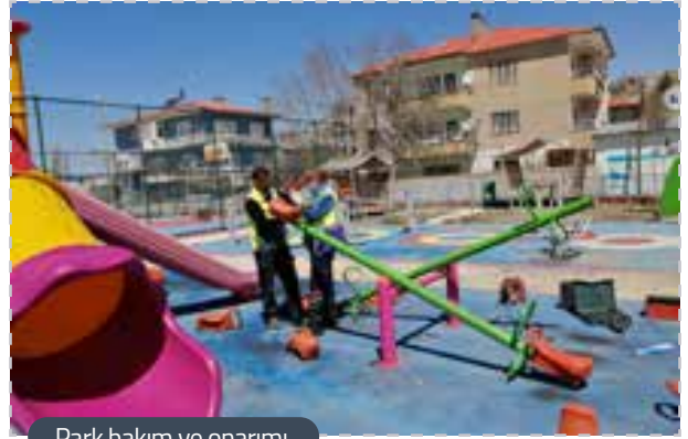
Park bakım ve onarımı
