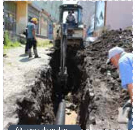
Alt yapı çalışmaları
