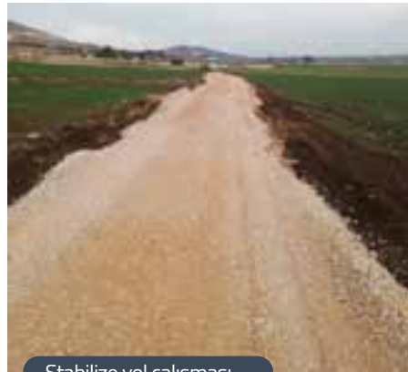
Stabilize yol çalışması
