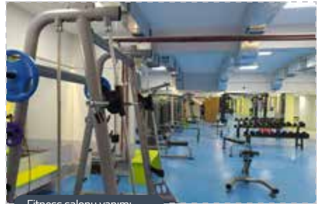
Fitness salonu yapımı
