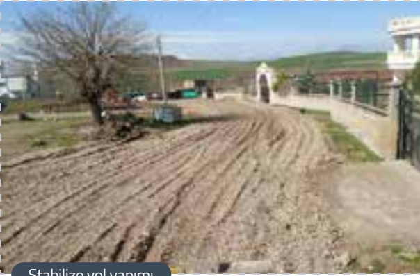
Stabilize yol yapımı
