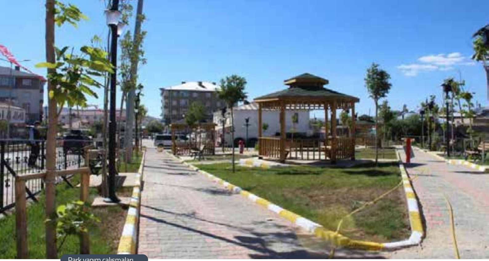
Park yapım çalışmaları
