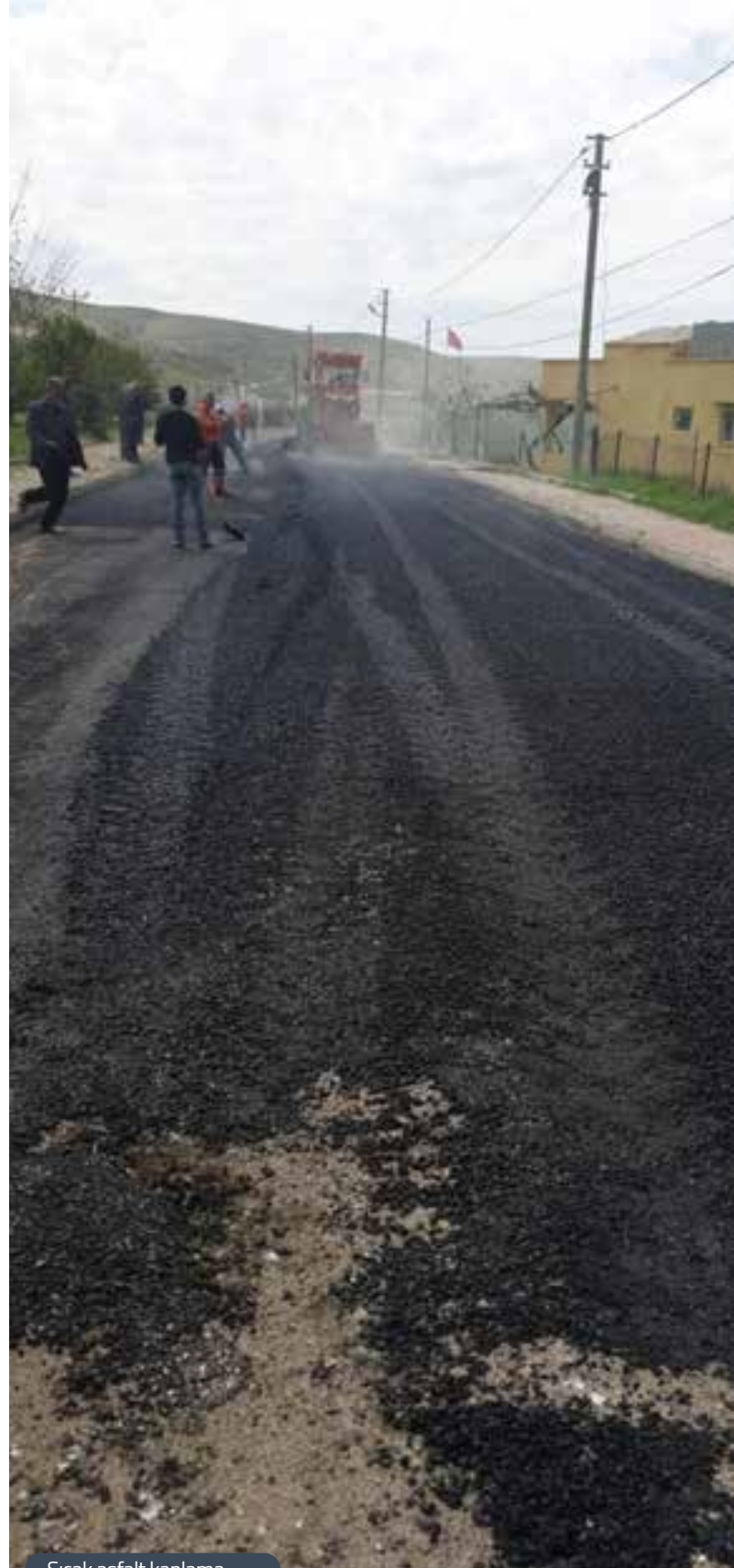
Sıcak asfalt kaplama
