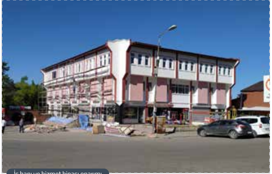
İş hani ve hizmet binası onarımı
