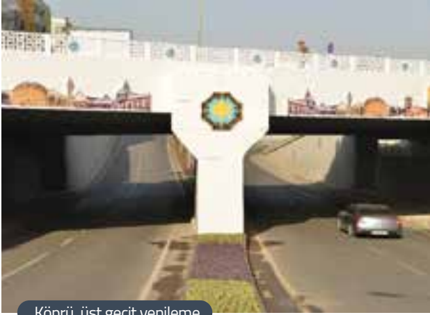
Köprü, üst geçit yenileme
