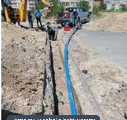
İme suyu Őebeke hattı yapımı
