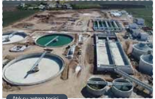
Atık su arıtma tesisi
