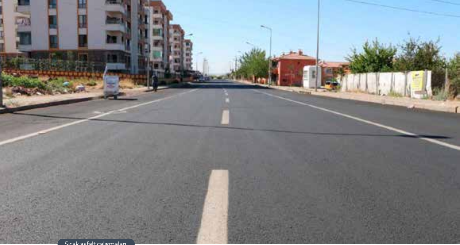
Sıcak asfalt çalışmaları
