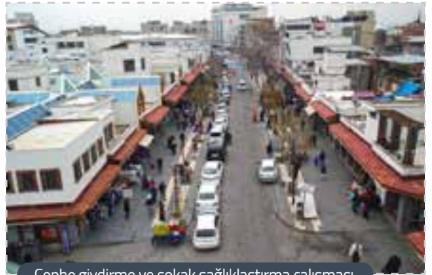
Cephe giydirme ve sokak sağlıklılaştırma çalışması
