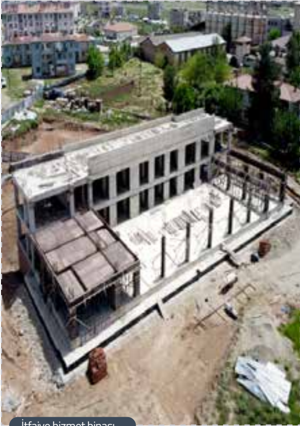
İtfaiye hizmet binası
