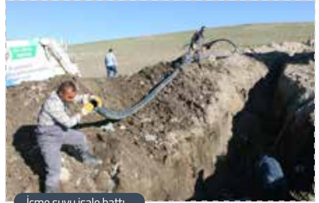
İçme suyu isale hattı
