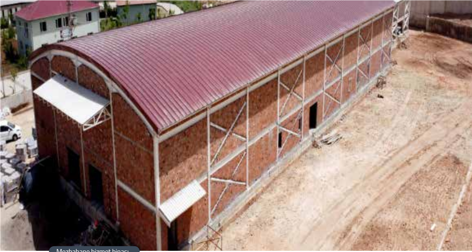
Mezbahane hizmet binası
