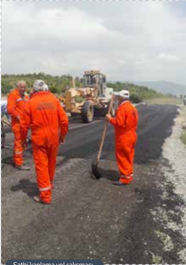
Sathi kaplama yol çalışması
