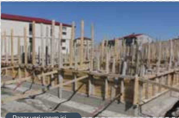
Pazar yeri yapım işi
