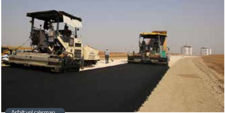
Asfalt yol alıŐması
