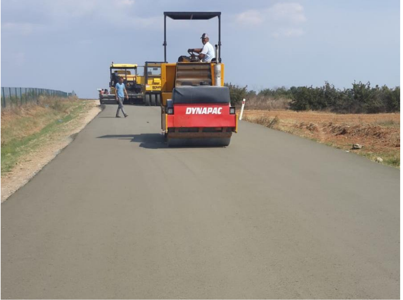
Sıkıştırılmış beton yol
