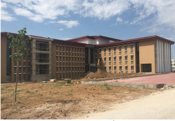
Kayalı Yerleşkesi 3. Merkezi Derslik İnşaatı
