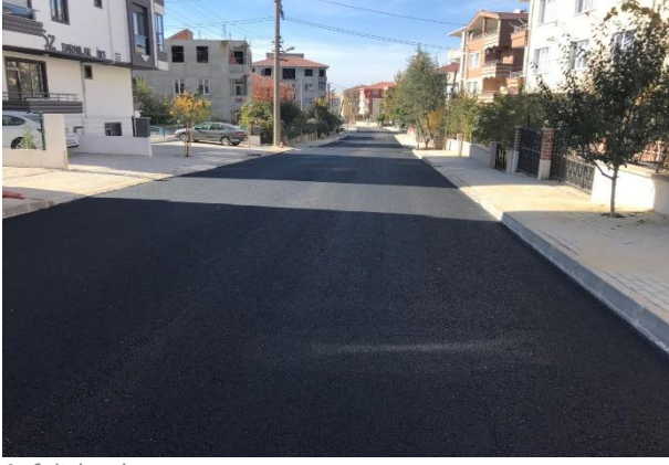
Asfalt kaplama yapımı
