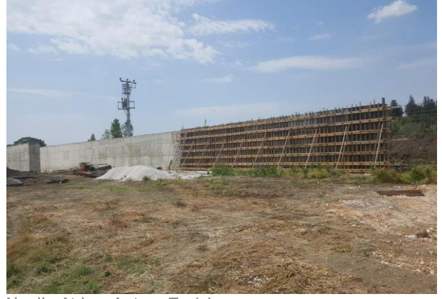
Alpullu Atıksu Arıtma Tesisi
