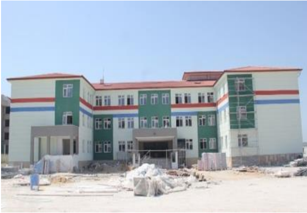
Lüleburgaz Zafer (Kurtuluş) Mahallesi Ortaokul İnşaatı
