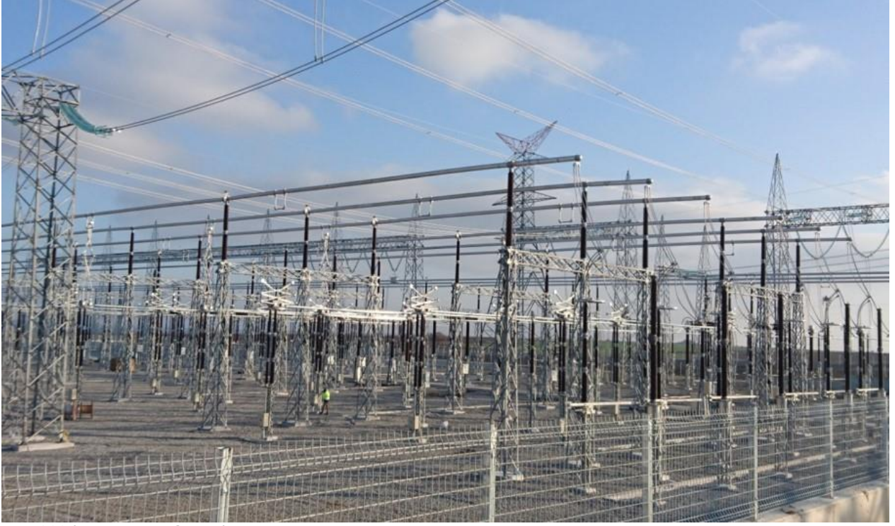
Vize 380 kV Havza Trafo Merkezi
