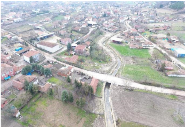
Lüleburgaz Ayvalı Taşkın koruması
