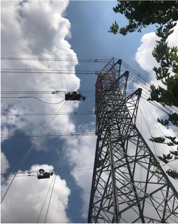
Traçim - Demirköy Enerji İletim Hattı
