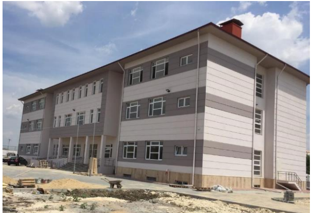
Lüleburgaz Mesleki Eğitim Merkezi İnşaatı
