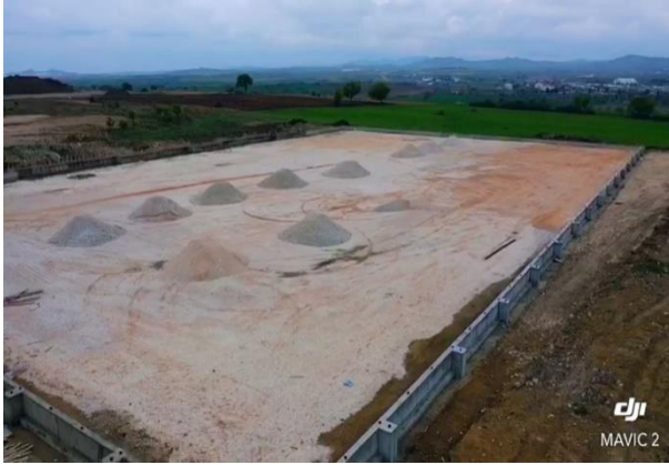
Kırklareli Sentetik Çim Yüzeyleli Hokey Sahası Yapımı
