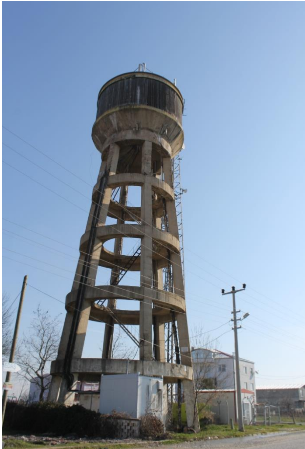
Kavaklı içmesuyu deposu
