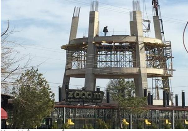
Kavaklı İçmesuyu İnşaati
