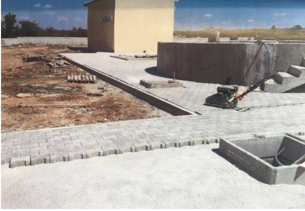
Karahalil Atıksu Arıtma Tesisi
