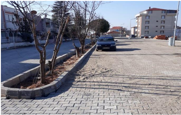
Kırklareli Parke Taş Yol Yapımı
