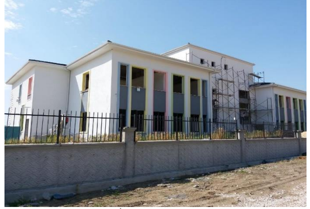
Lüleburgaz Anaokulu İnşaatı
