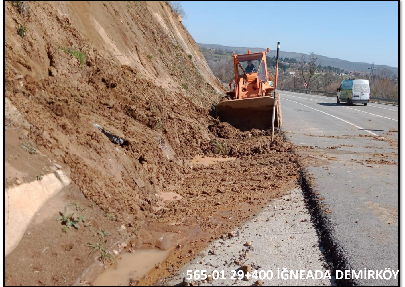
565-01 DEMİRKÖY YOLU HENDEK TEMİZLİK ÇALIŞMALARI
