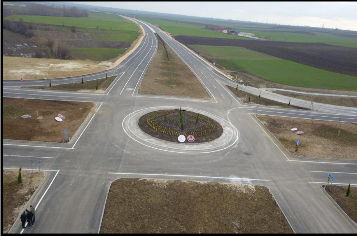
Lüleburgaz TEM Kavşağı Km:52+150
