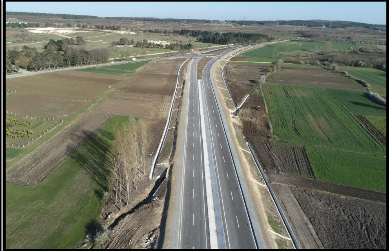
Çakıllı Çevre Yolu Giriş Kavş. Km:11+600
