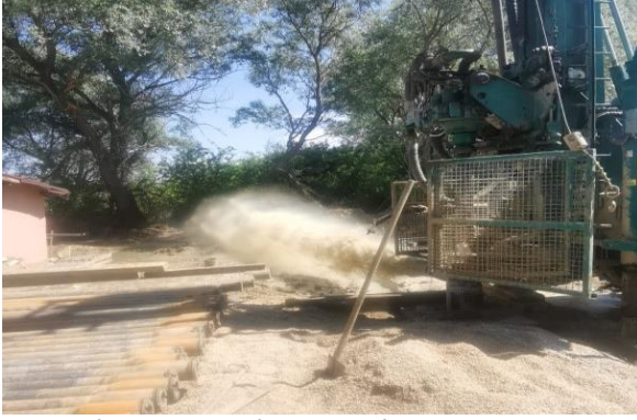
Evrensekiz içmesuyu kuyusu açılması
