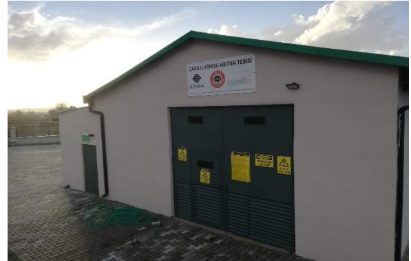
Çakıllı atıksu arıtma tesisi
