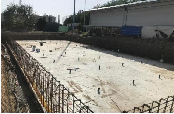
Lüleburgaz Yüzme Havuzu
