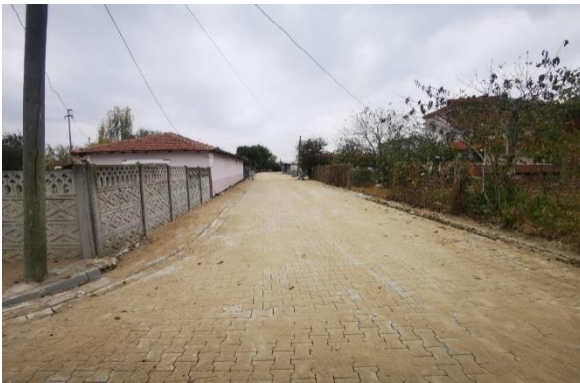
İller Bankası Evrensekiz şehir içi yol yapımı
