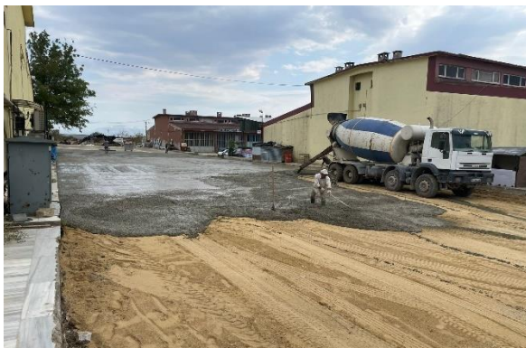
Vize beton yol yapımı
