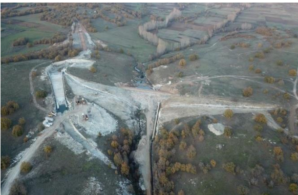
Pınarhisar Yenice Barajı
