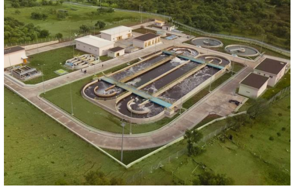
Büyükkarıştıran OSB Atıksu Arıtma Tesisi
