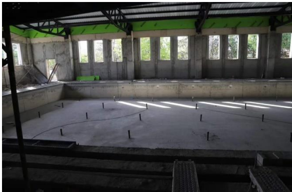
Lüleburgaz Yüzme Havuzu
