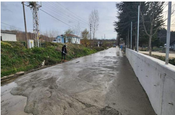
Demirköy yol yapımı
