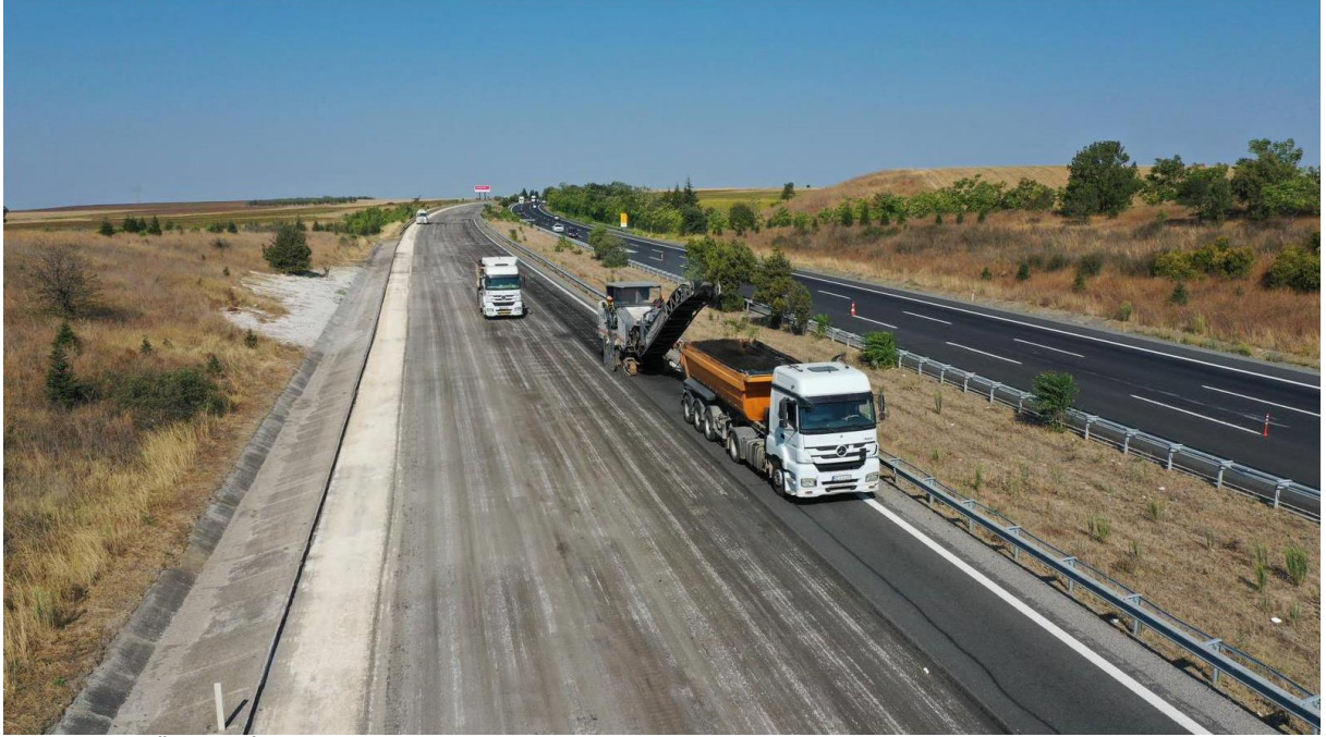
TEM Otoyolu Üstyapı İyileřtirmesi ve Büyük Onarımı
