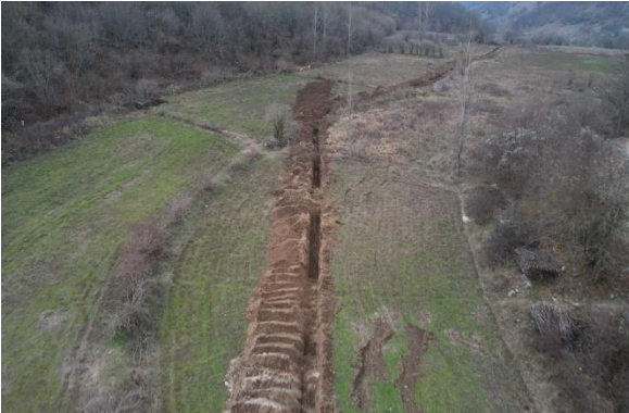
Merkez Kuzulu içmesuyu 4.200 metrelik isale hattı yenilendi.
