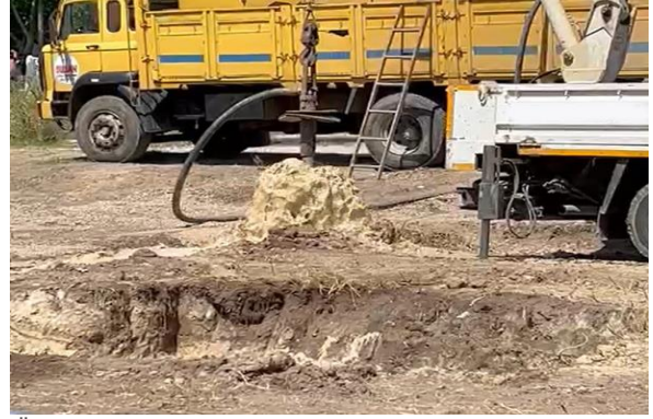
Ürnlü kuyu sondajı
