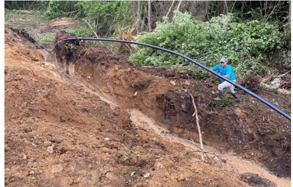
Vize Kışlacık içmesuyu 4.000 metre ilave isale hattı döşendi.
