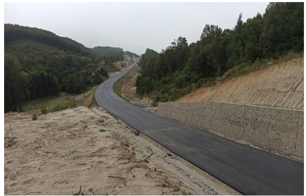
Demirköy çevre yolu
