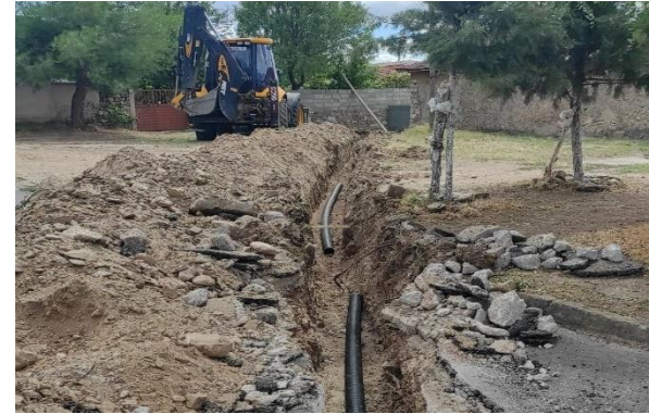
Üsküp kanalizasyon çalışmaları
