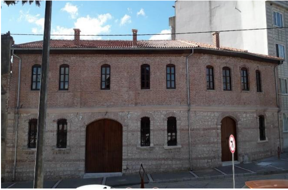
Kırklareli Merkez Yayla Mahallesi 728 ada 40 parselde bulunan yapı restore edilmiş, geçici kabulü yapılmış ve yapı kullanım izni alınmıştır
