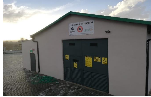
Çakıllı paket atıksu arıtma tesisi
