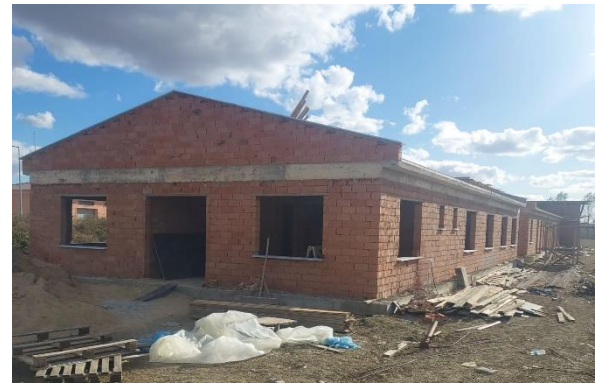
Vize Geçici Hayvan Barınağı yapımı
