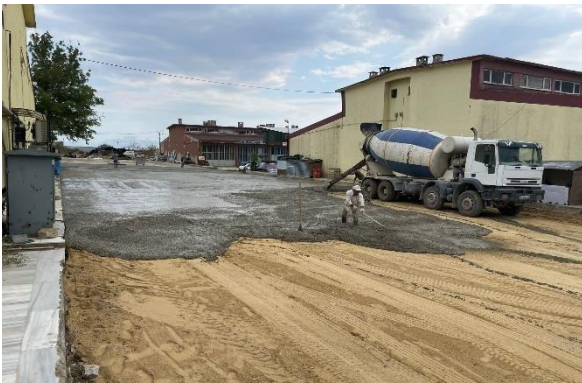
Vize beton yol yapımı
