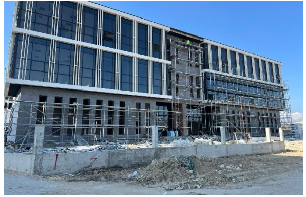
Tapu ve Kadastro Hizmet Binası
