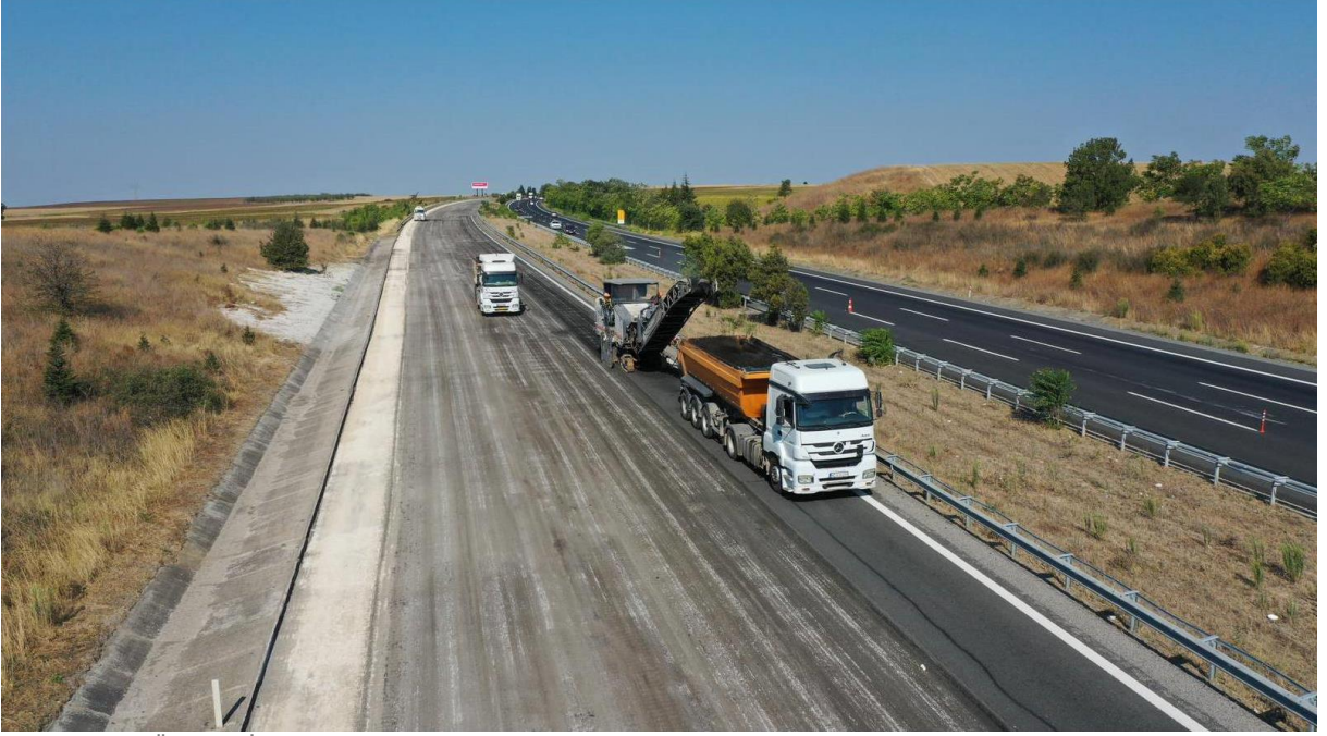
TEM Otoyolu Üstyapı İyileştirmesi ve Büyük Onarımı
