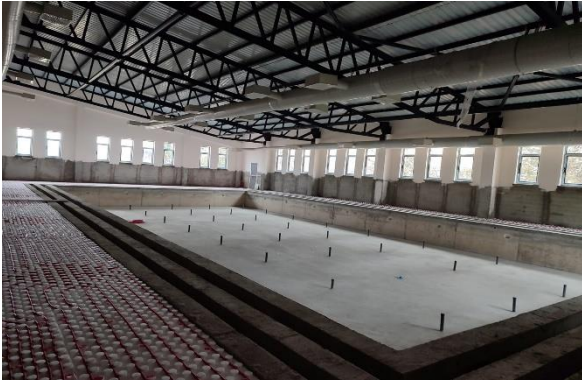
Lüleburgaz Yüzme Havuzu
