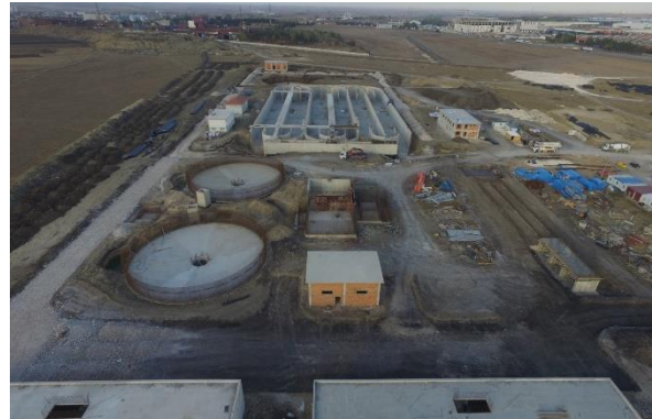
Büyükkarıştıran OSB Atıksu Arıtma Tesisi
