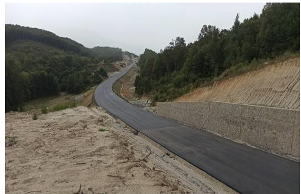
Demirköy çevre yolu
