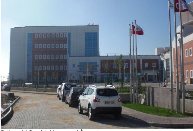
Babaeski Devlet Hastanesi İnşaatı
