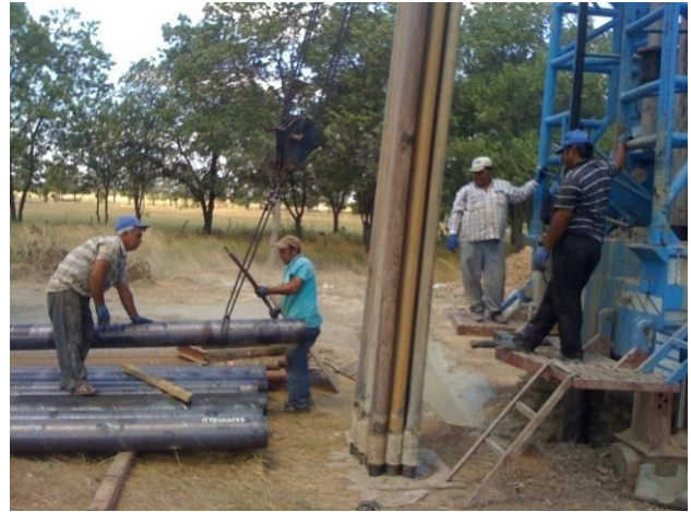
Özden Kışlası Kuyu Sondajı
