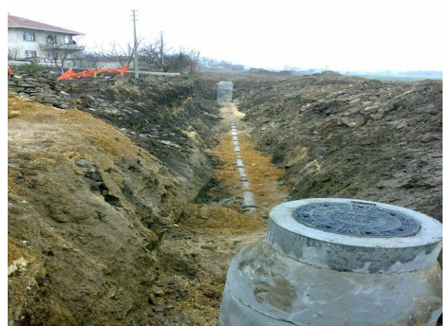
Vize Çakıllı Kanalizasyon Şebeke İnşaatı
