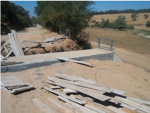
Kofçaz Beyci 1 Menfız İnşaatı
