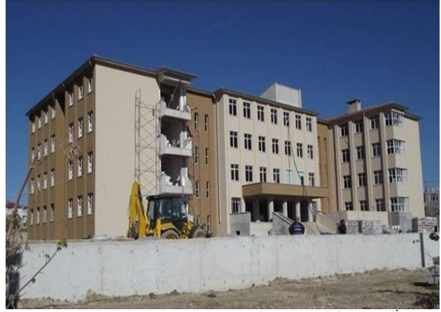
Pınarhisar Anadolu Lisesi İnşaatı
