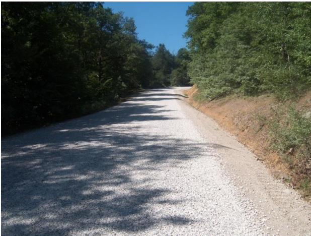
Yeşilce – Karacadağ 1. Kat Asfalt Kaplama
