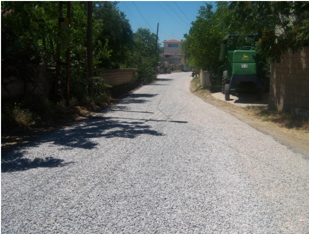
Kızılcıkdere Köyiçi 2. Kat Asfalt Kaplama
