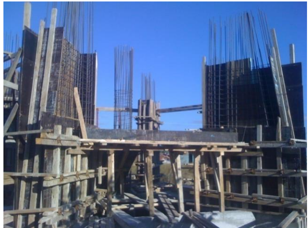
Lüleburgaz Akçaköy İçmesuyu Ayaklı Su Deposu İnşaatı
