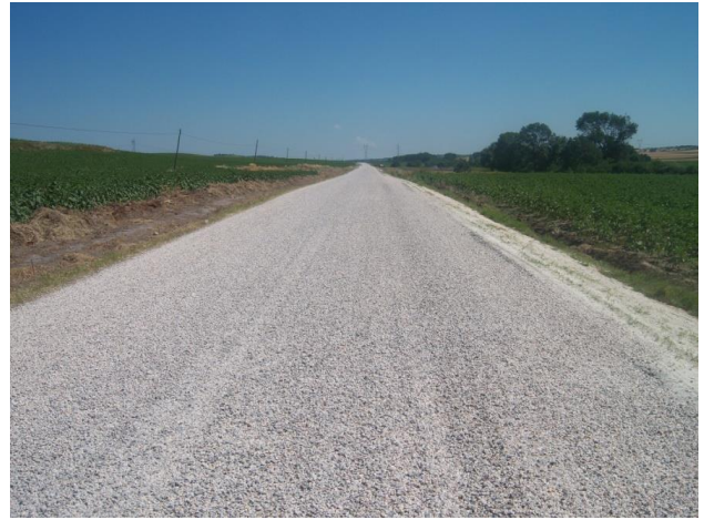
Devlet yolu İltihak – Müsellim 2. Kat Asfalt Kaplaması
