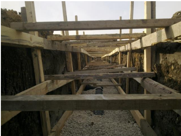
L.burgaz Evrensekiz Kanalizasyon İnşaatı
