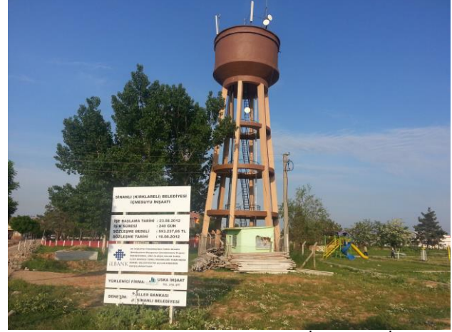
Babaeski Sinanlı İçmesuyu İnşaatı
