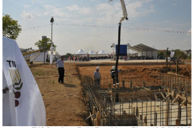
TMO Depolama Tesisi Temel Atma Töreni 19 Eylül 2012
