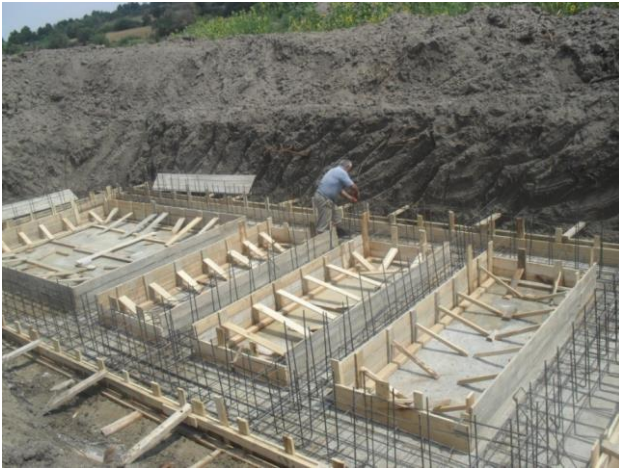
Babaeski Sofuhalil Kanalizasyon İnşaatı
