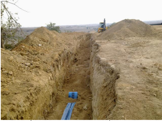
Babaeski İçmesuyu Terfi Hattı Yapım İnşaatı
