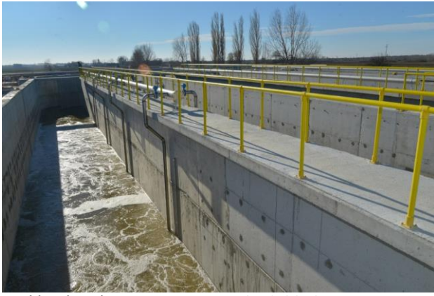
Kırklareli Atıksu Arıtma Tesisi 12.12.2013
