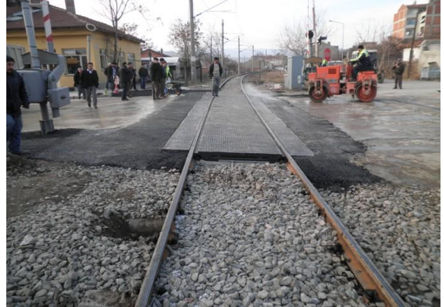
Geçit Kaplama Çalışmaları
