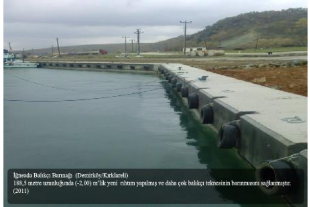
İğneada Balıkçı Barınağı Rıhtım Yenileme Çalışması (2012)
