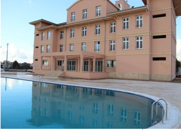
Kırklareli Anadolu Otelcilik ve Turizm Meslek Lisesi İnşaatı
