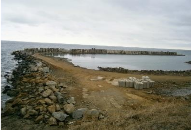
Beğendik Balıkçı Barınağı İnşaatı
