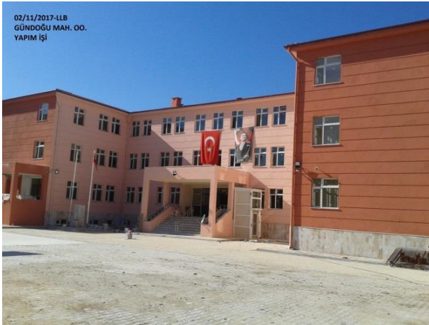
Lüleburgaz Gündoğdu Mahallesi İlkokul İnşaatı
