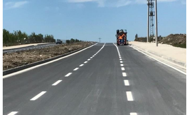
Çetin Yelmez Bulvarı Sıcak Asfalt 1 nci Kısım
