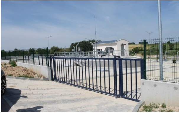
Kavaklı Atıksu Arıtma Tesisi
