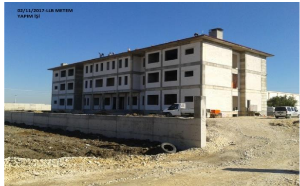
Lüleburgaz Mesleki Eğitim Merkezi İnşaatı
