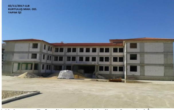
Lüleburgaz Zafer (Kurtuluş) Mahallesi Ortaokul İnşaatı
