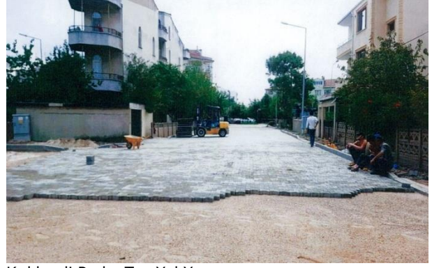
Kırklareli Parke Taş Yol Yapımı
