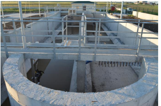
Evrensekiz Atıksu Arıtma Tesisi
