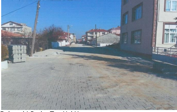
Babaeski Parke Taş Yol Yapımı
