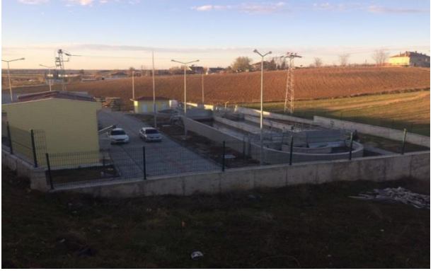
Büyükmandıra Atıksu Arıtma Tesisi
