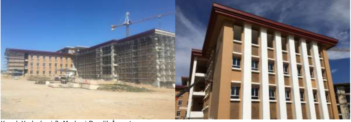
Kayalı Yerleşkesi 3. Merkezi Derslik İnşaatı
