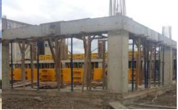
Lüleburgaz Dövenciler AL Spor Salonu İnşaatı
