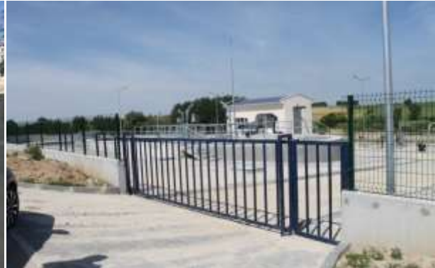
Kavaklı Atıksu Arıtma Tesisi
