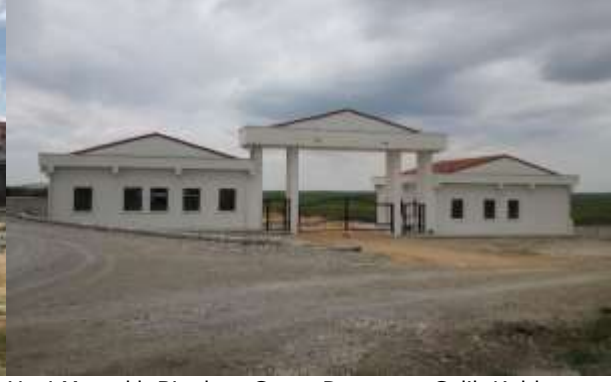
Yeni Mezarlık Binaları, Çevre Duvarı ve Çelik Kubbe
