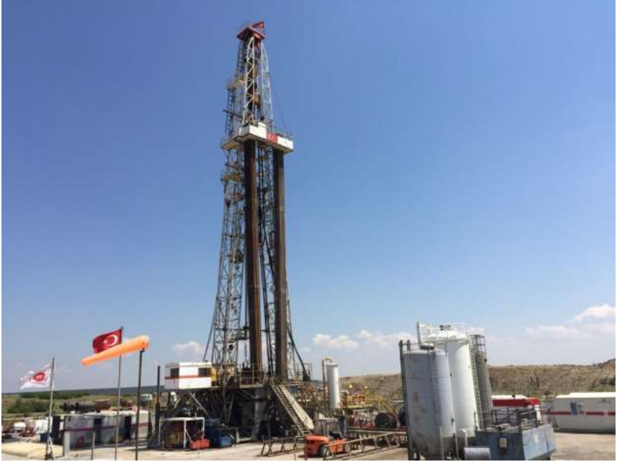
Batı Mesutlu-1 Kuyusu Kuyu Tamamlama Operasyonları
