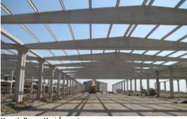
Kapalı Pazar Yeri İnşaatı
