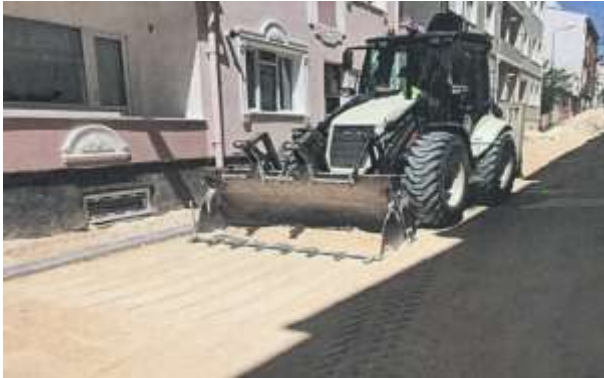
Kırklareli Parke Taş Yol Yapımı
