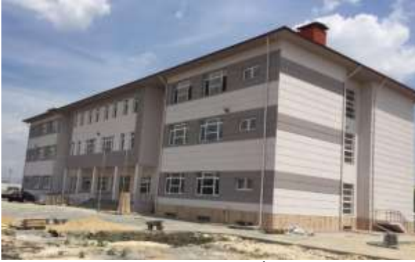
Lüleburgaz Mesleki Eğitim Merkezi İnşaatı
