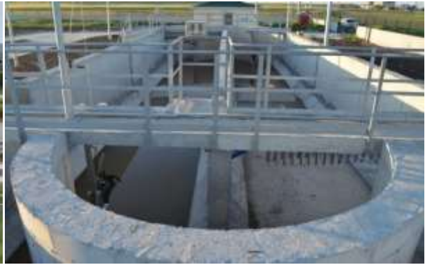
Evrensekiz Atıksu Arıtma Tesisi
