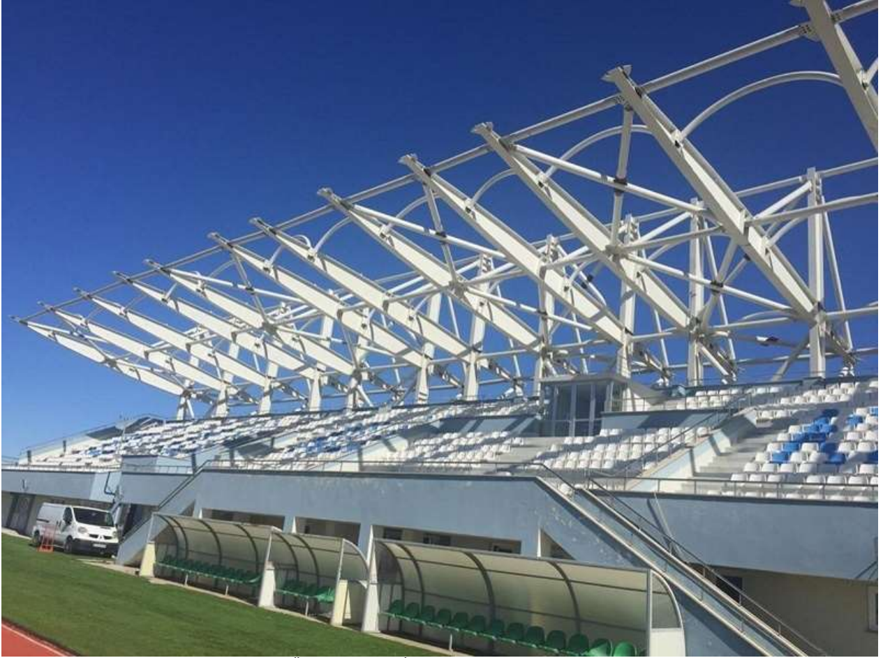
Kayalı Yerleşkesi Futbol Sahası Tribün Üstü Kapatma İnşaatı
