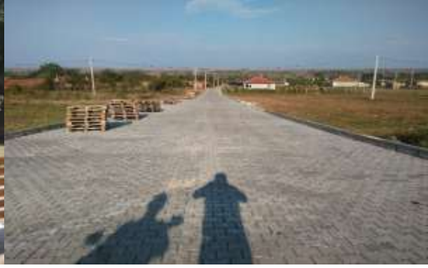
Karahalil Şehirçi Yolları Parke Taş Kaplaması
