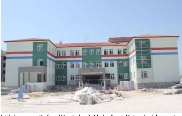
Lüleburgaz Zafer (Kurtuluş) Mahallesi Ortaokul İnşaatı
