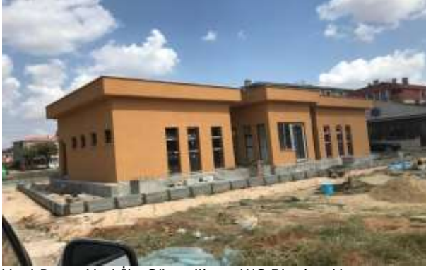
Yeni Pazar Yeri İle Güvenlik ve WC Binaları Yapımı
