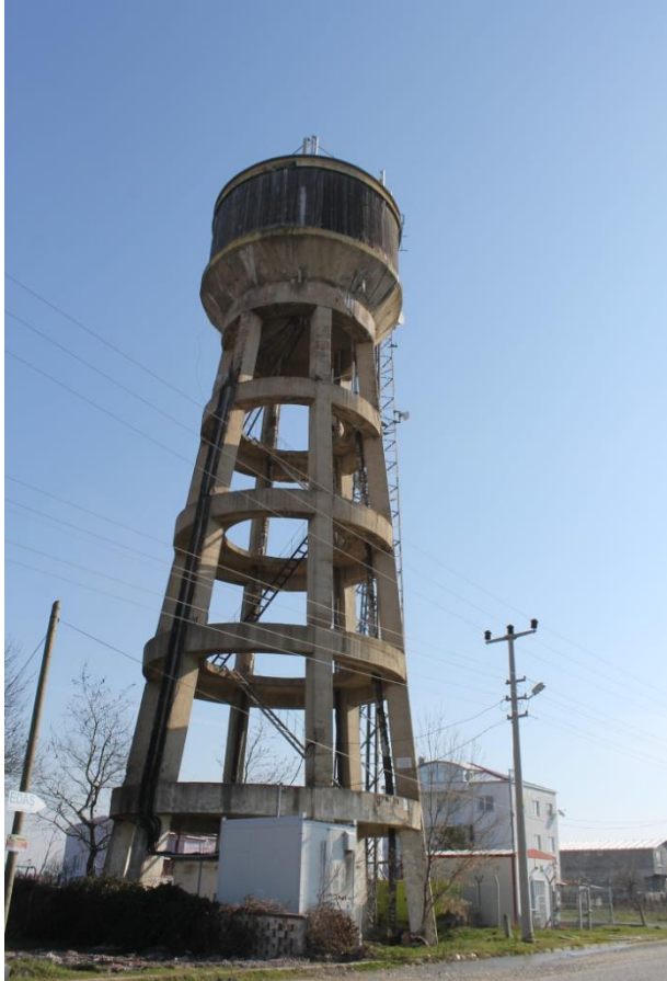
Kavaklı içmesuyu deposu
