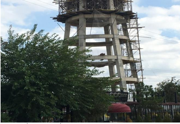
Kavaklı İçmesuyu İnşaati
