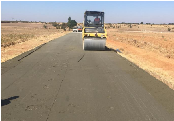
Kavakdere Beton Yol Yapımı
