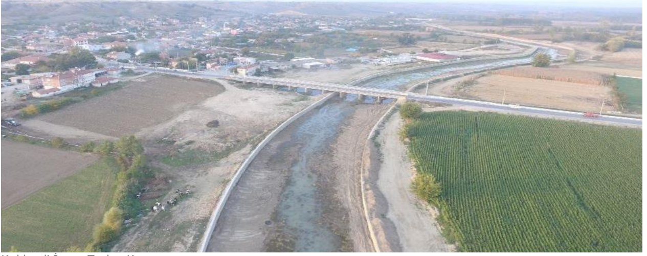
Kırklareli İnece Taşkın Koruması
