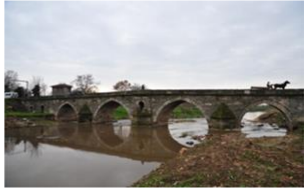
Tarihi Lüleburgaz (Sokullu Mehmet Paşa) Köprüsü
