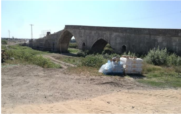
Alpullu (Sinanlı) Köprüsü
