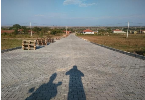
Karahalil parke taş yol yapımı
