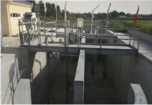
Karahalil Atıksu Arıtma Tesisi
