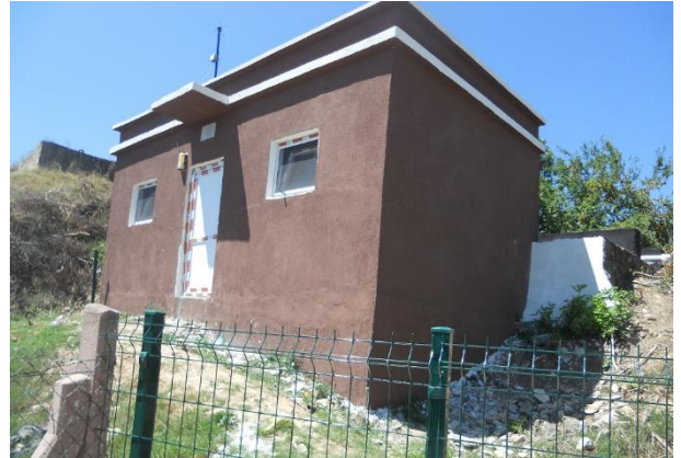
Vize Küçükayla Gömme Depo Bakım ve Onarımı
