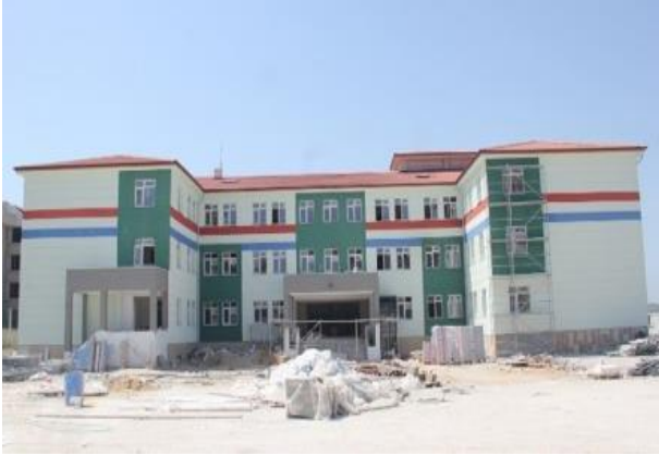
Lüleburgaz Zafer (Kurtuluş) Mahallesi Ortaokul İnşaati
