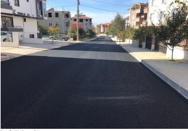
Asfalt kaplama yapımı
