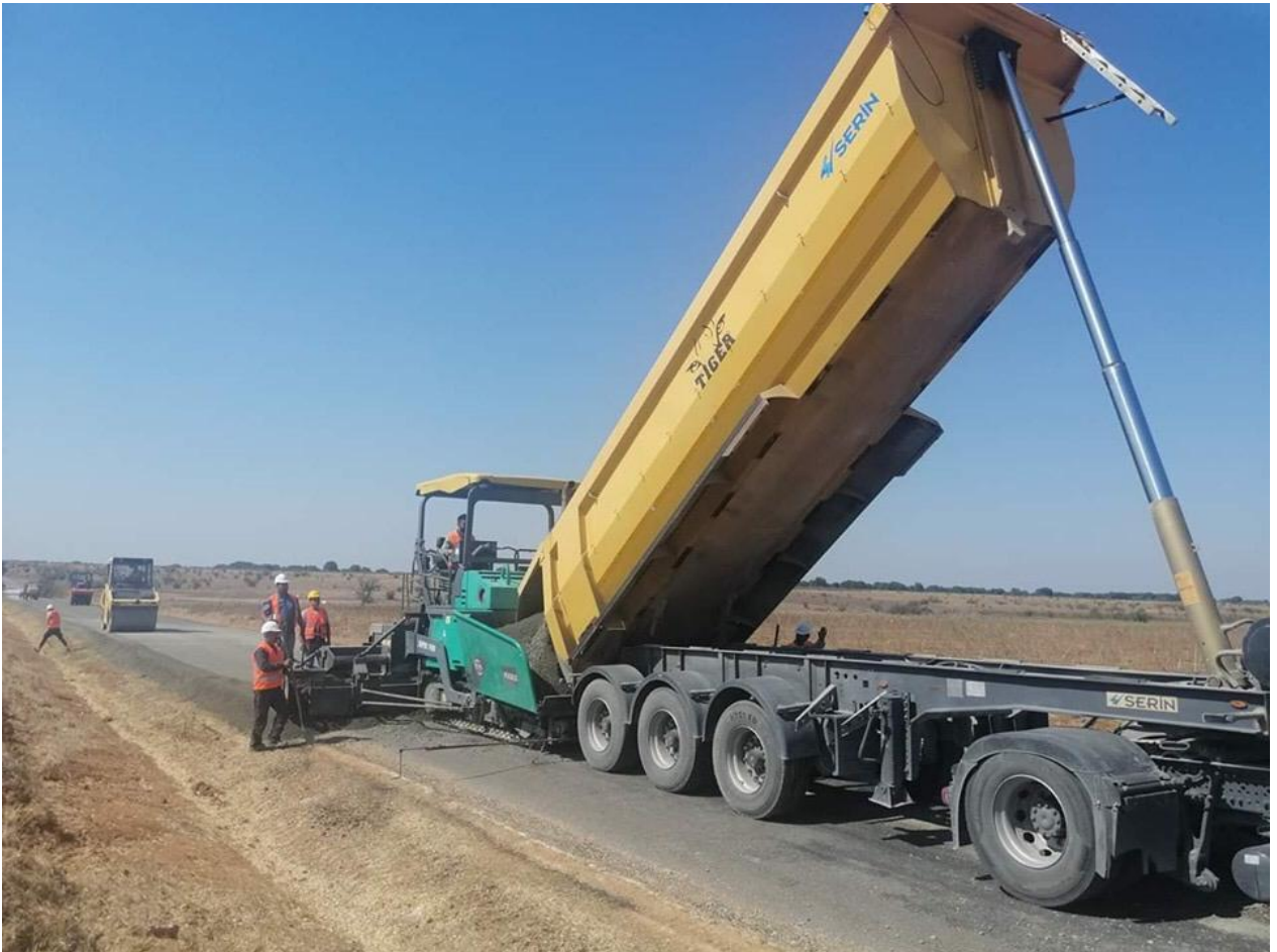
Sıkıştırılmış beton yol
