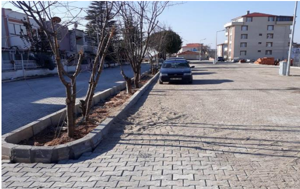
Kırklareli Parke Taş Yol Yapımı
