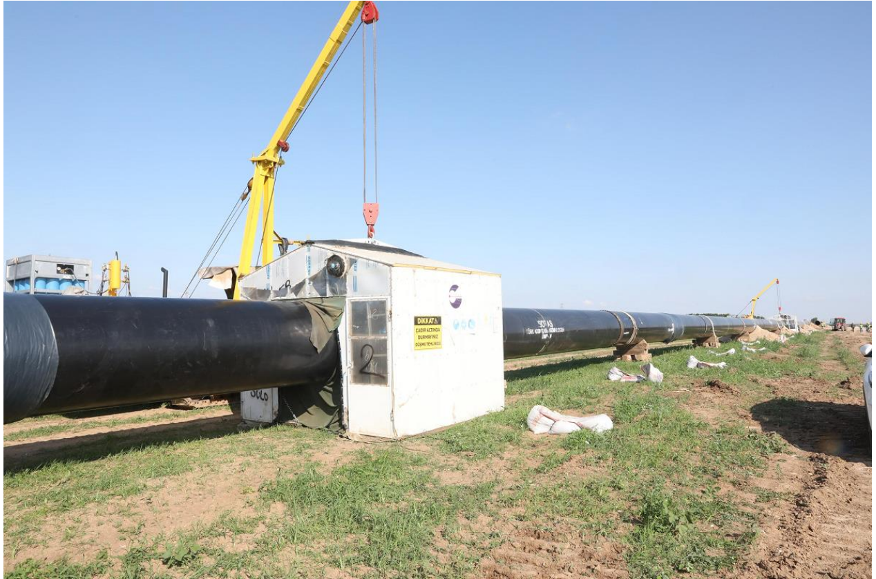
Türk Akımı Kara Kısmı -1 Doğal Gaz Boru Hattı Çalışmaları
