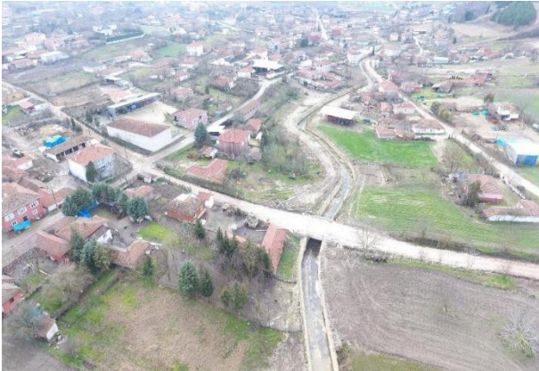
Lüleburgaz Ayvalı Taşkın Koruması
