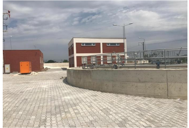
Pehlivan köyü Atıksu Arıtma Tesisi
