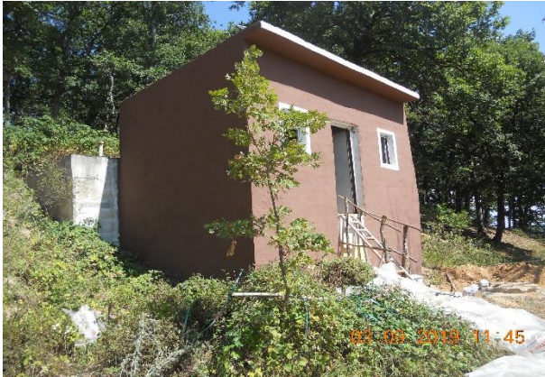
İçmesuyu Depo Bakım ve Onarımları
