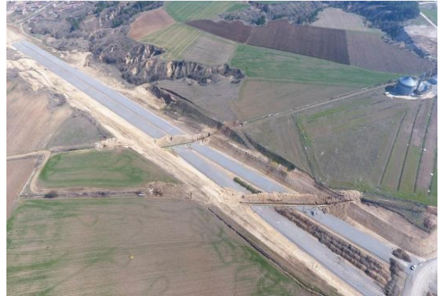
Kayalı Kanalet Deplasmanı
