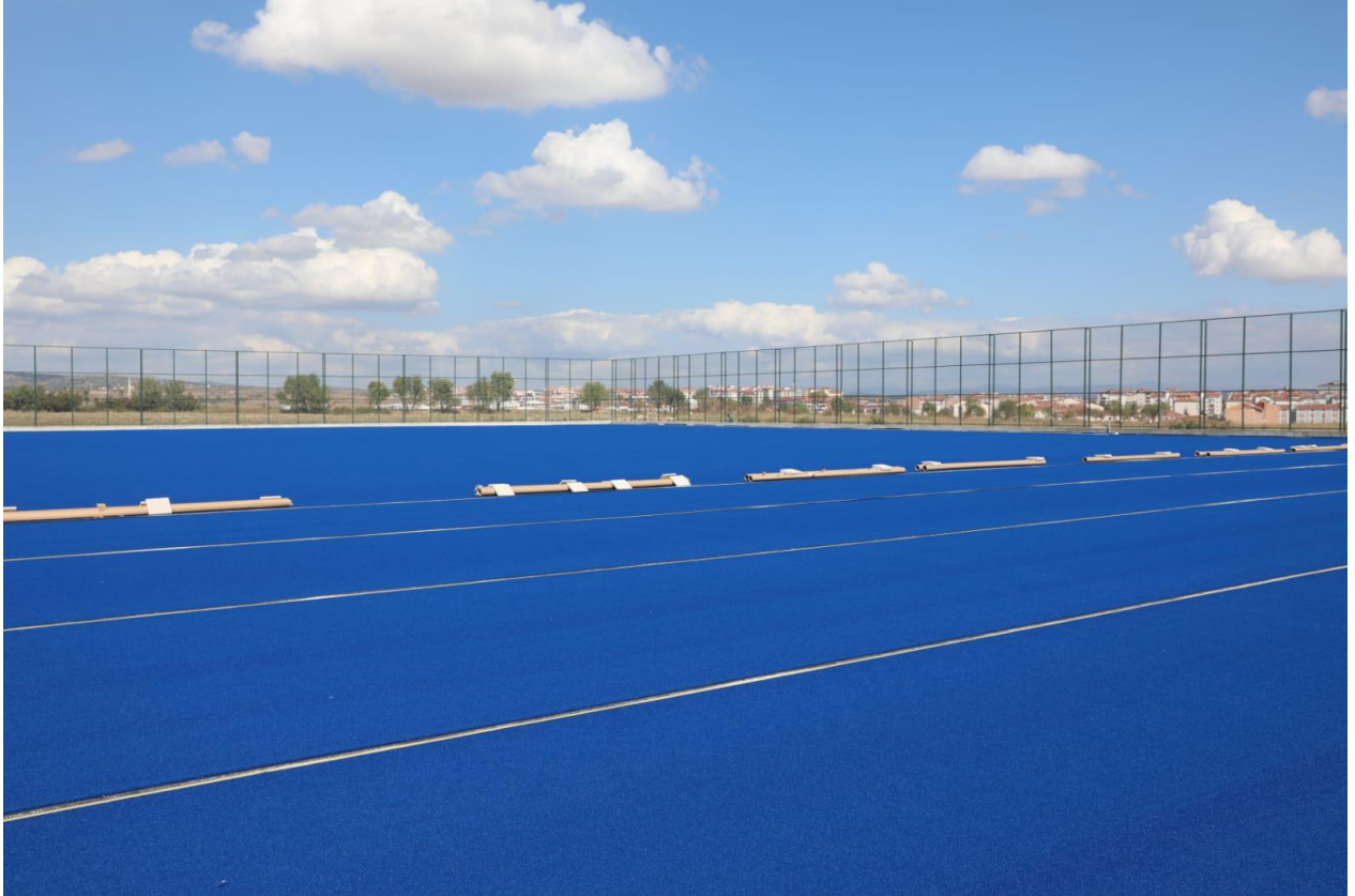
Kırklareli Sentetik Çim Yüzeyleli Hokey Sahası Yapımı
