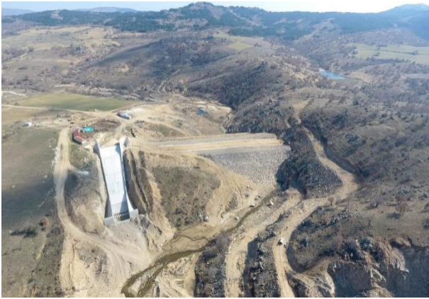
Merkez Kadıköy Barajı
