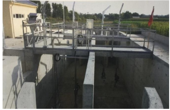
Karahalil Atıksu Arıtma Tesisi
