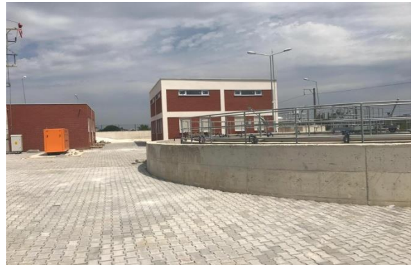
Pehlivan köy Atıksu Arıtma Tesisi
