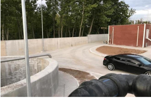
Kaynarca Atıksu Arıtma Tesisi
