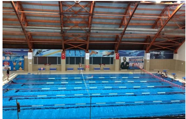
Kırlareli Kapalı Yzme Havuzu Bakım ve Onarımı
