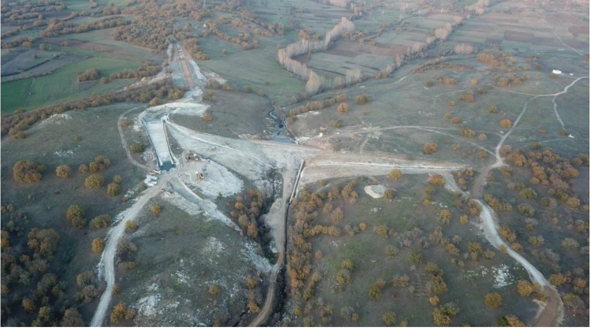
Pınarhisar Yenice Barajı ve Sulaması
