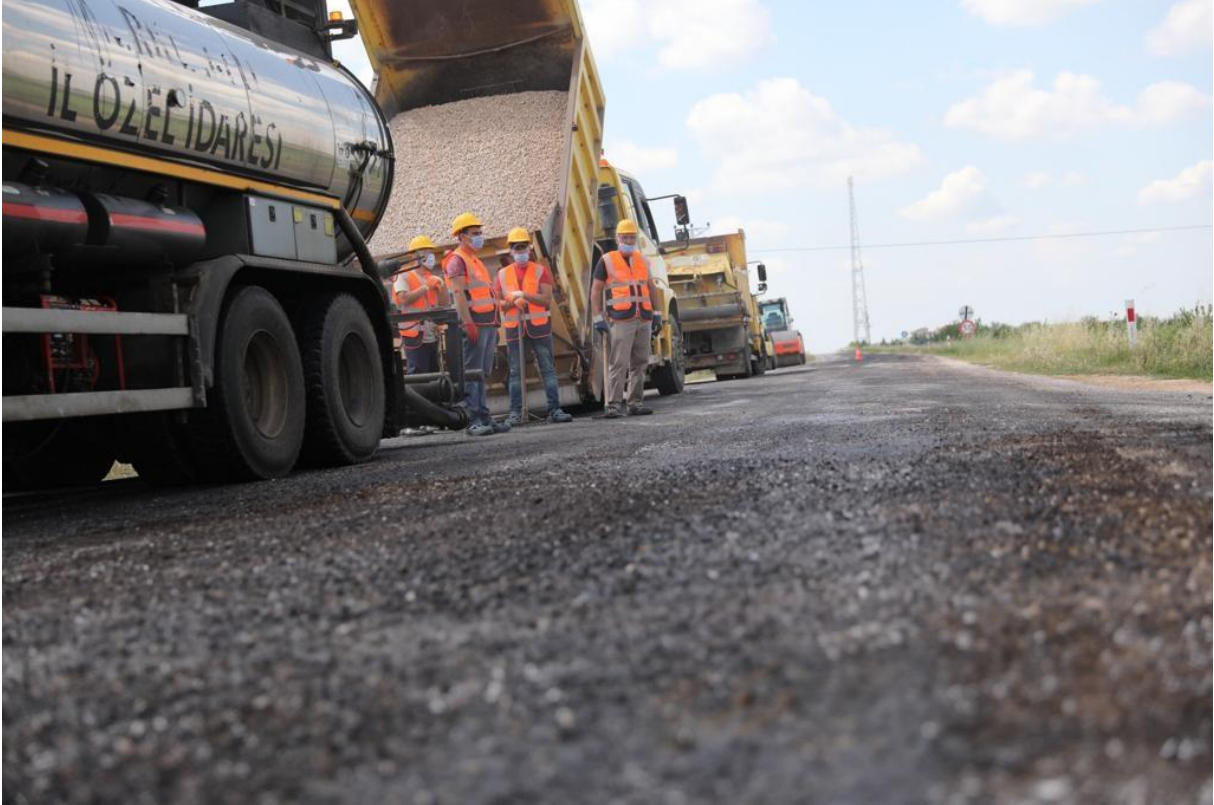
Kızılıkdere – Deveçatağı yol çalışması 22.06.2020
