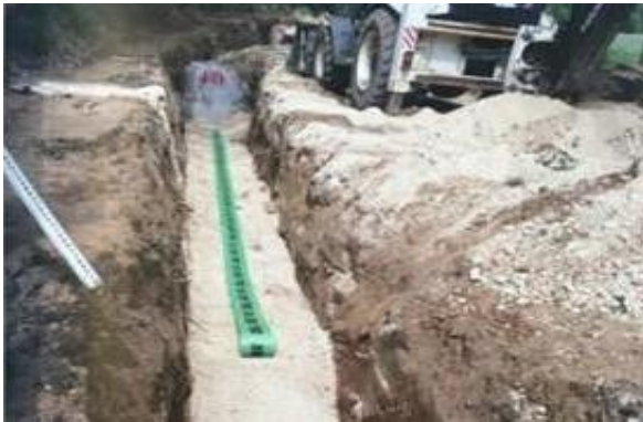
Demirköy Kanalizasyon ve Yağmursuyu
