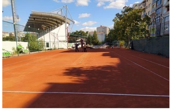
Kırlareli Merkez Ađık Tenis Kortları Bakım ve Onarımı
