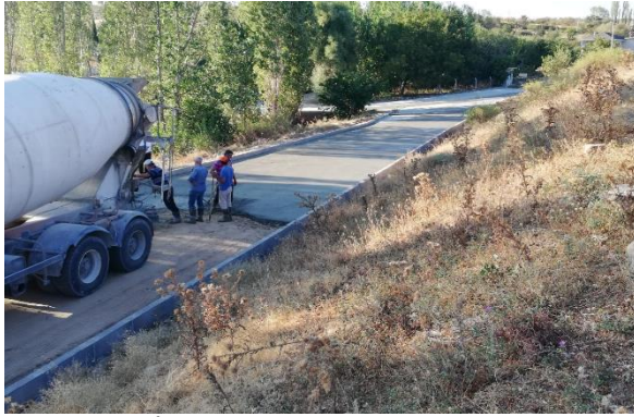
Yol çalışmasıİçmesuyu çalışmaları
