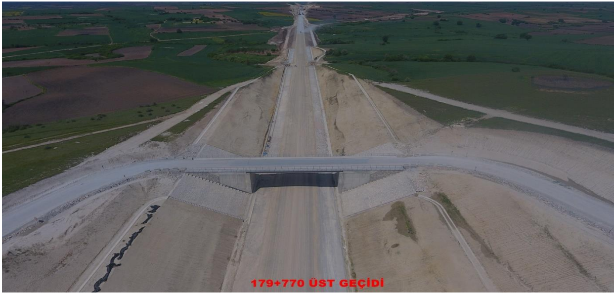
Halkalı – Kapıkule Yüksek Standartlı Demiryolu İnşaatı
