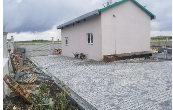
Çakıllı atıksu arıtma tesisi
