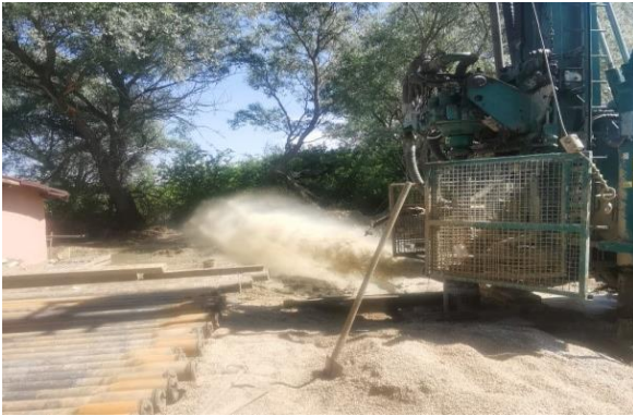
Evrensekiz içmesuyu kuyusu açılması
